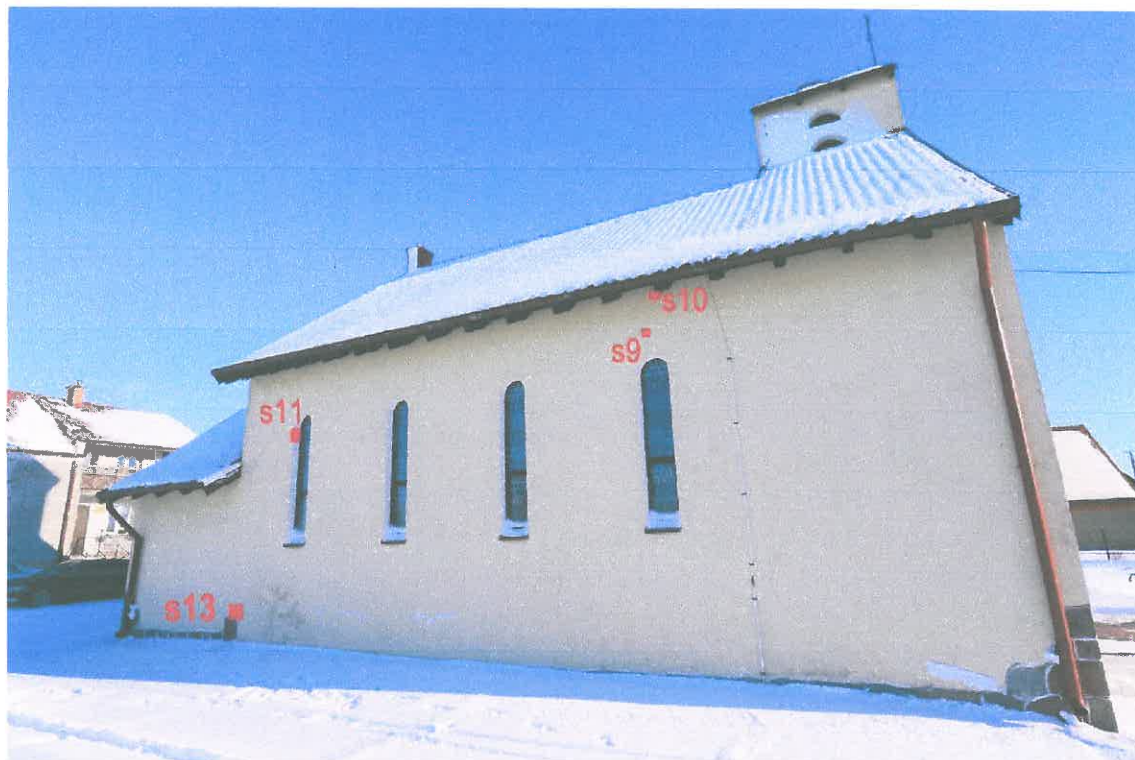
Elewacja zachodnia- lokalizacja odkrywek
