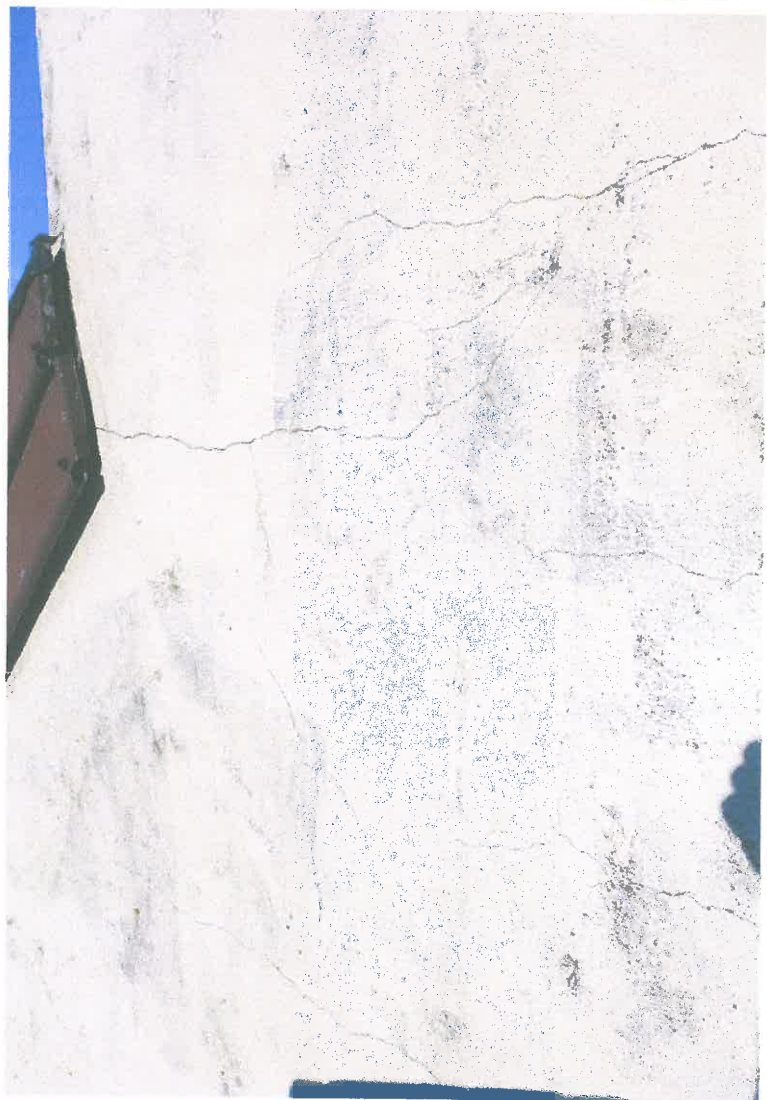
Widok spękań do przeszycia
