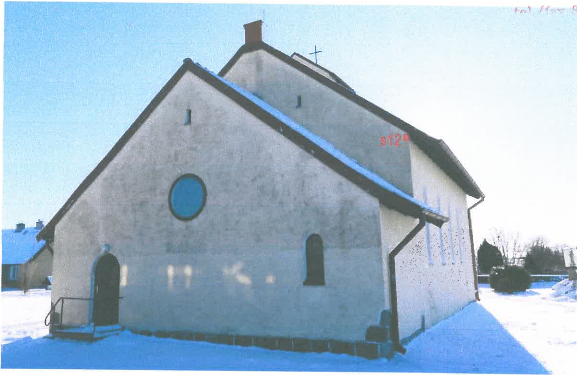
Widok elewacji północnej z lokalizacją odkrywki
