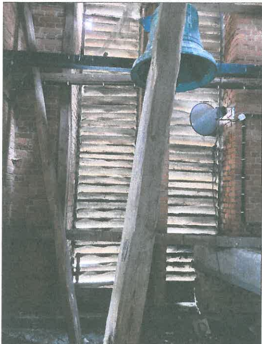
FOT.49 ŻALUZJE WIEŻY ZACHODNIEJ.
