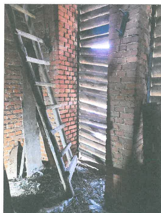
FOT.46 ŻALUZJE WIEŻY ZACHODNIEJ.
