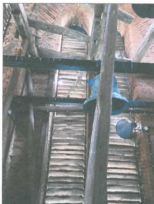
FOT.45 ŻALUZJE WIEŻY ZACHODNIEJ.
