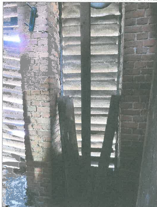
FOT.50 ŻALUZJE WIEŻY ZACHODNIEJ.
