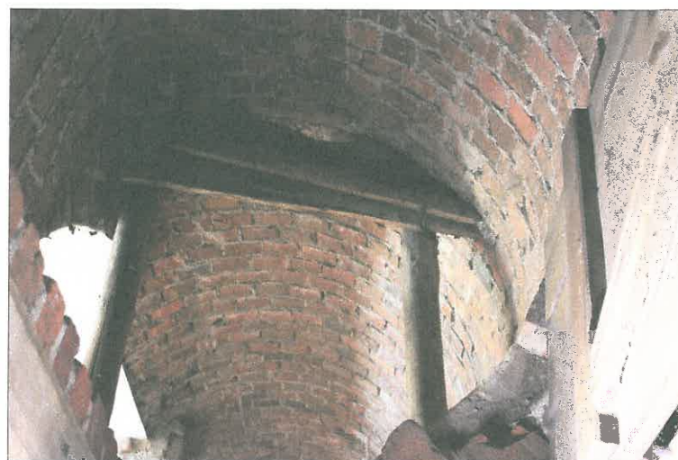
FOT.44 WEJŚCIE NA WIEŻĘ ZACHODNIĄ.
