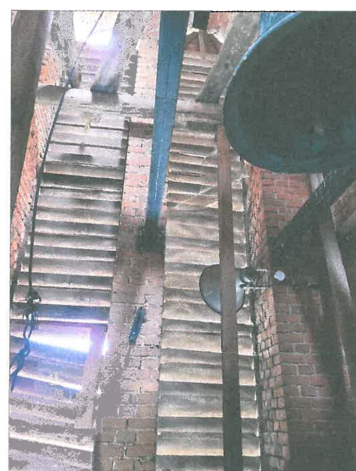
FOT.47 ŻALUZJE WIEŻY ZACHODNIEJ.
