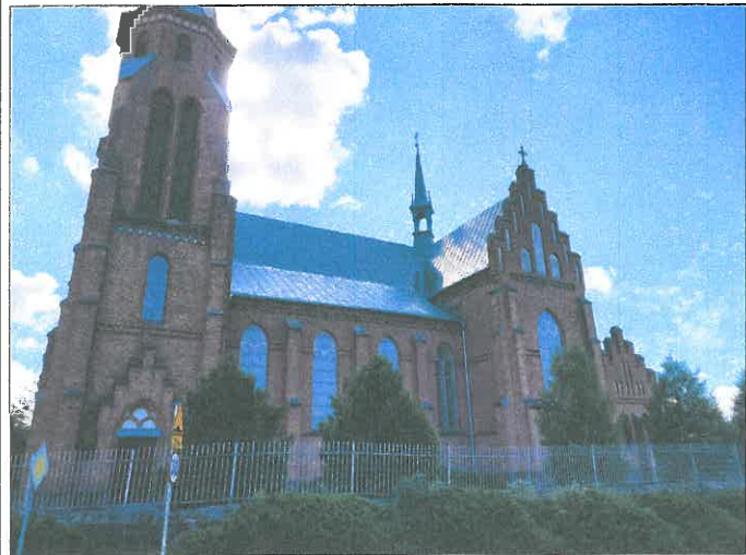
FOT. 1 ELEWACJA ZACHODNIA.
