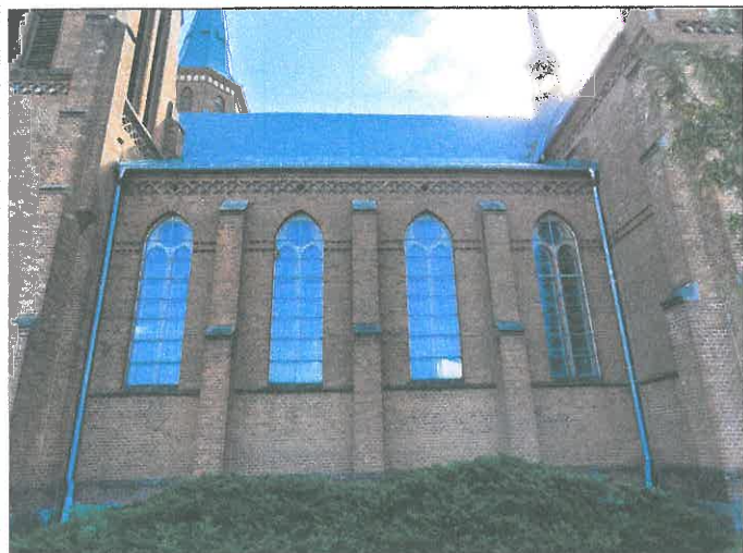
FOT. 3 ELEWACJA ZACHODNIA.
