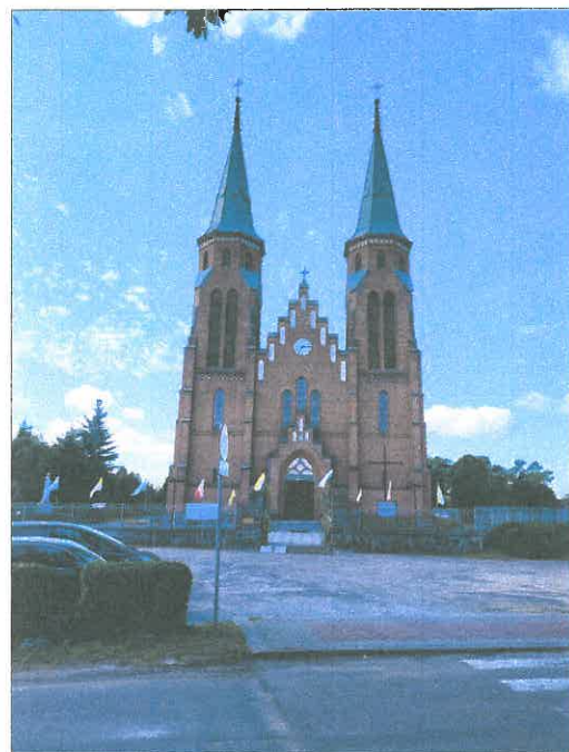
FOT. 4 ELEWACJA PÓŁNOCNA.
