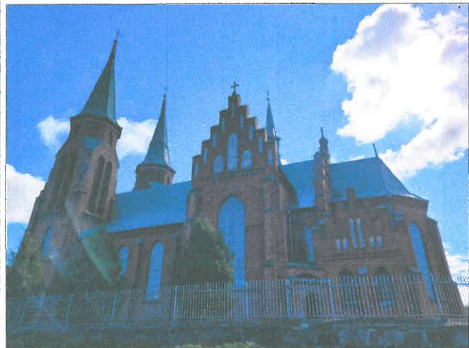
FOT. 2 ELEWACJA ZACHODNIA.
