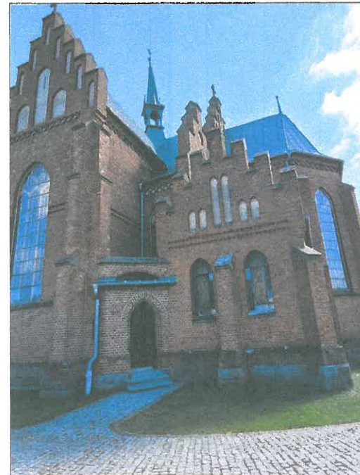
FOT. 9 ELEWACJA ZACHODNIA.
