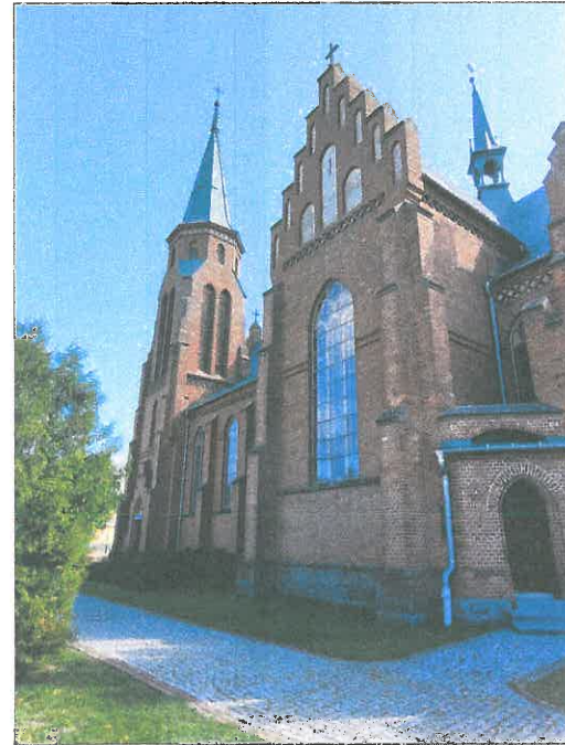
FOT. 8 ELEWACJA ZACHODNIA.
