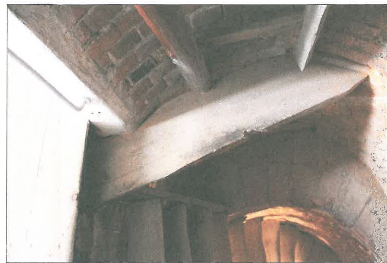
FOT.36 WEJŚCIE NA WIEŻĘ ZACHODNIĄ.
