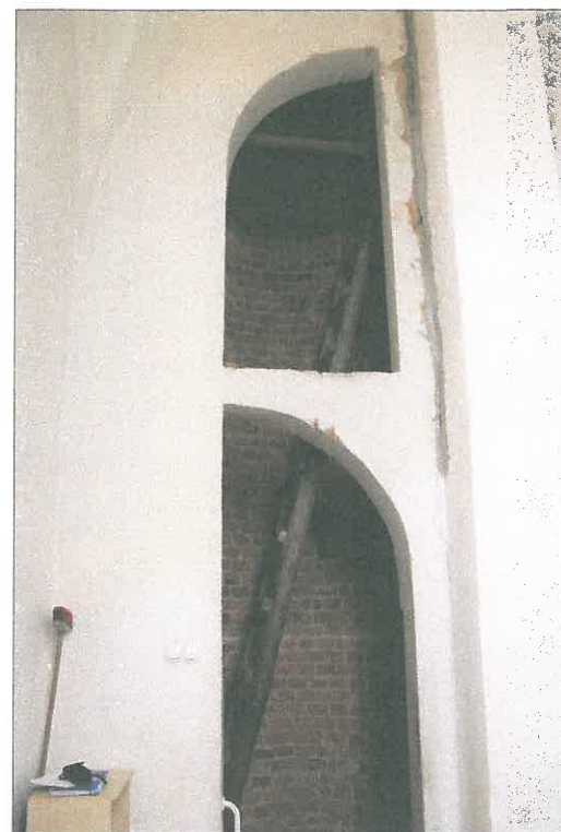
FOT.35 WEJŚCIE NA WIEŻĘ ZACHODNIĄ.
