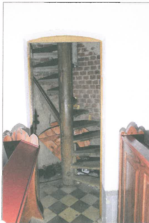
FOT.34 WEJŚCIE NA WIEŻĘ ZACHODNIĄ.
