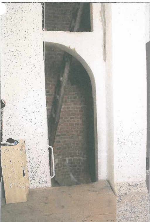
FOT.40 WEJŚCIE NA WIEŻĘ ZACHODNIĄ.
